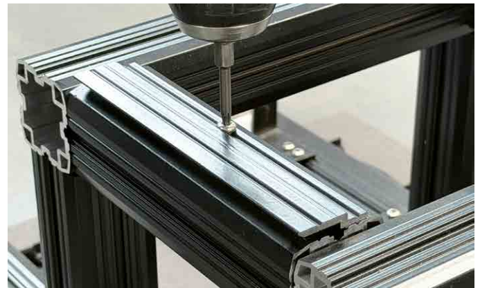
Z-Profil auf der Aluminium-Unterkonstruktion positionieren und befestigen.
