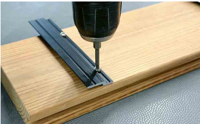
Z-Profil an der Deckbelag-Unterseite ausrichten und verschrauben.
