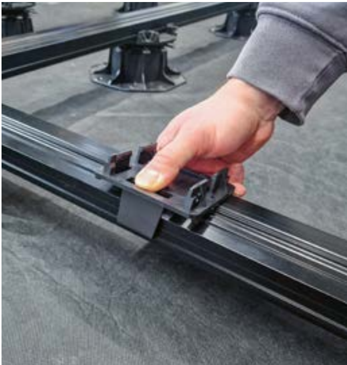
KL-Kreuzverbinder auf die ausgerichtete Konterlattung einklicken
