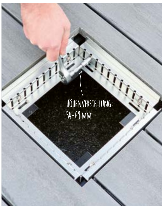
Höhe des Revisionskastens an den Terrassenbelag anpassen
