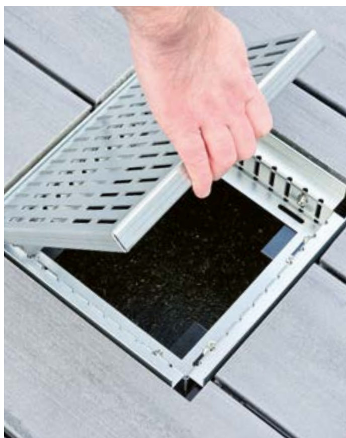
Abdeckblech in den montierten Kasten einlegen
