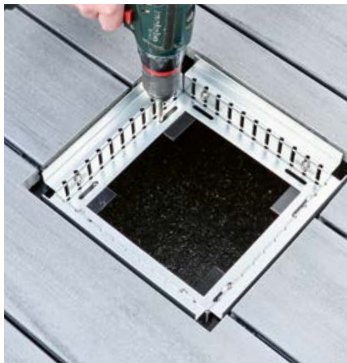
Revisionskasten einsetzen und an Windlastträger verschrauben
