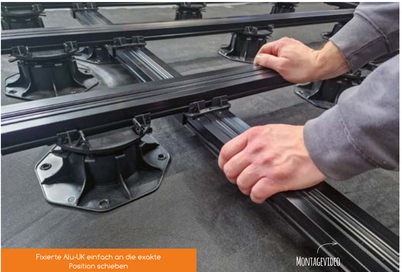
KL-Kreuzverbinder auf die ausgerichtete Konterlattung einklicken
